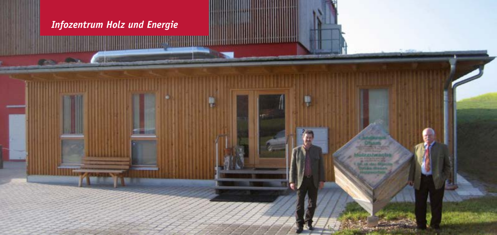
Im neuen direkt neben dem Biomasseheizkraftwerk gelegenen Infozentrum gibt es Informationen aus erster Hand.
